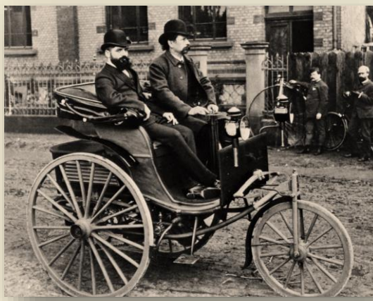
Прогулянка з «Патентованим автомобілем Бенца». Замість спицьованих коліс, у моделі III встановлено дерев'яні колеса, які були набагато міцнішими за поганих дорожніх умов.
