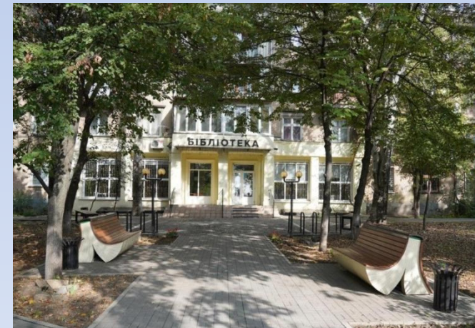
Музей архітектури м. Запоріжжя Музей створено за адресою вул. Гоголя, 66. Для цього було відремонтовано та облаштовано підвал під однією з міських бібліотек.
