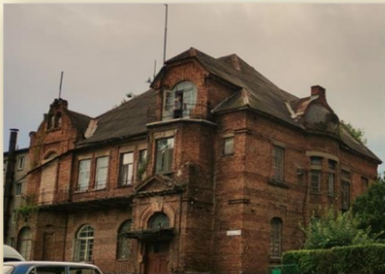
Комплекс будинку К.Валльманн на вул. Розенталь, 7
